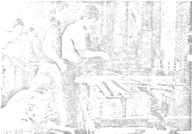
Rys. 14. Budowa toru o długości 12 m składającego się z 54 zespołów elektromagnesów trójfazowych dla pojazdów modelowych „Dynoplan” oraz „taksówki elektrodynamicznej”
